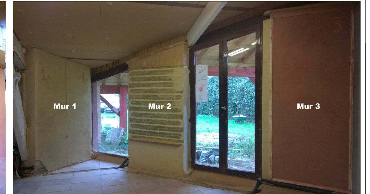
Vue intérieure des murs tests
