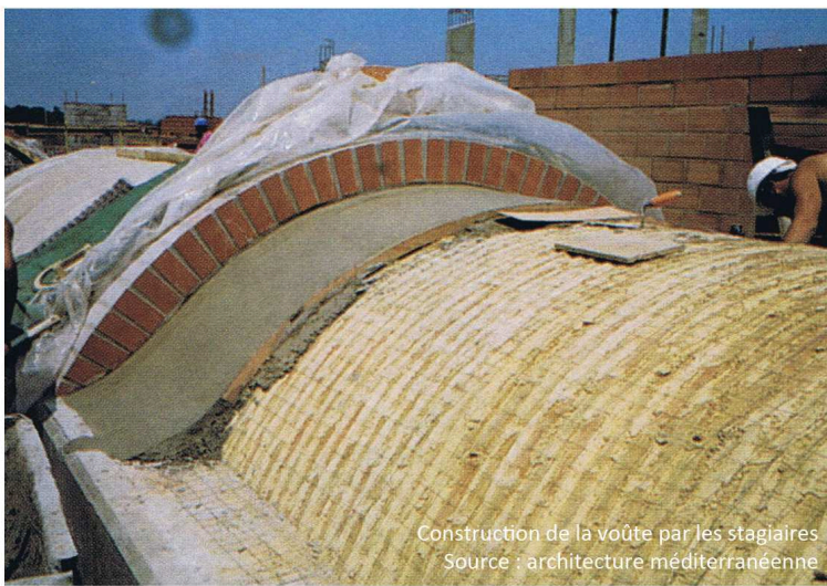
Construction de la voûte par les stagiaires Source : architecture méditerranéenne
