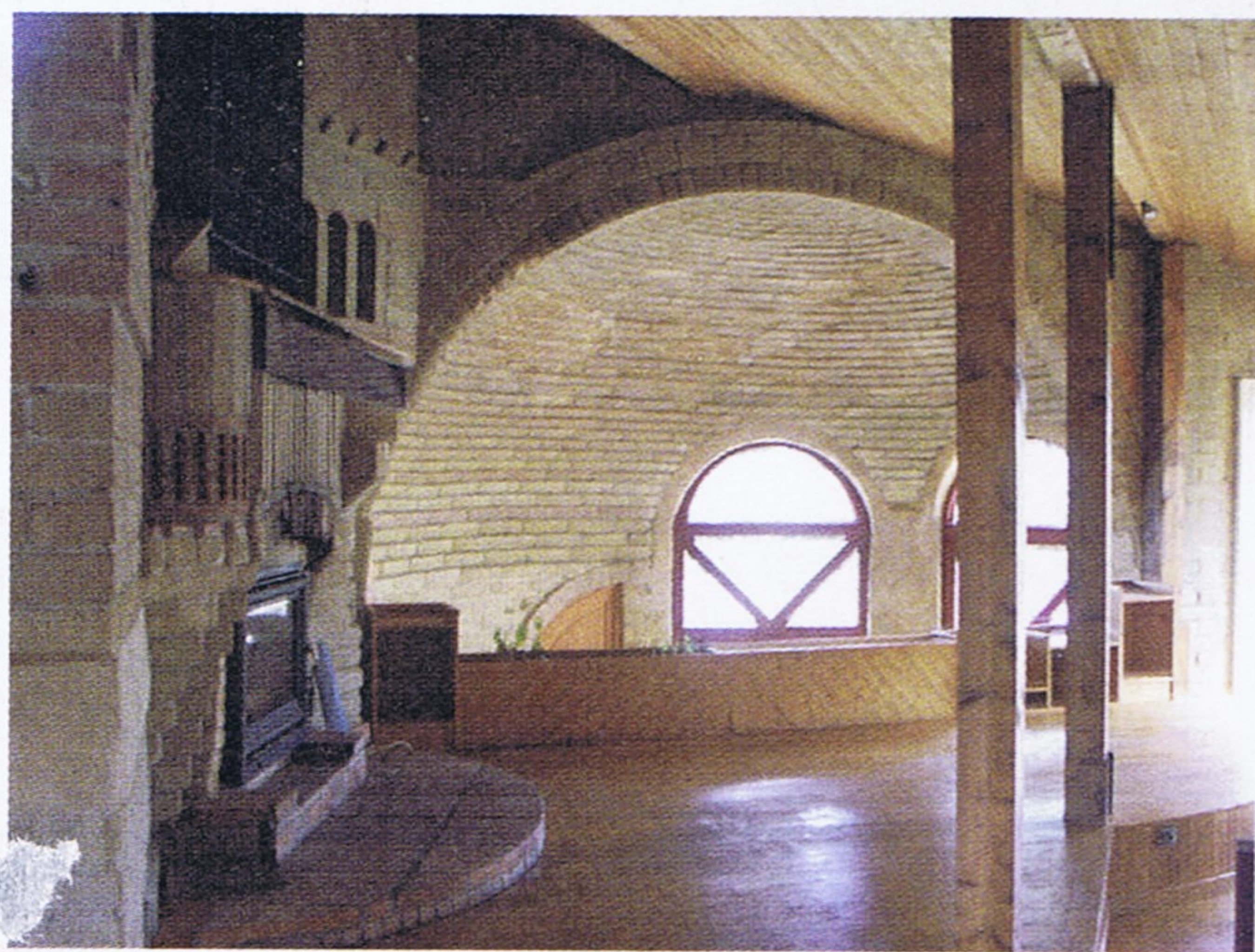
La terre crue maintient une stabilité hygrométrique à l'intérieur.
