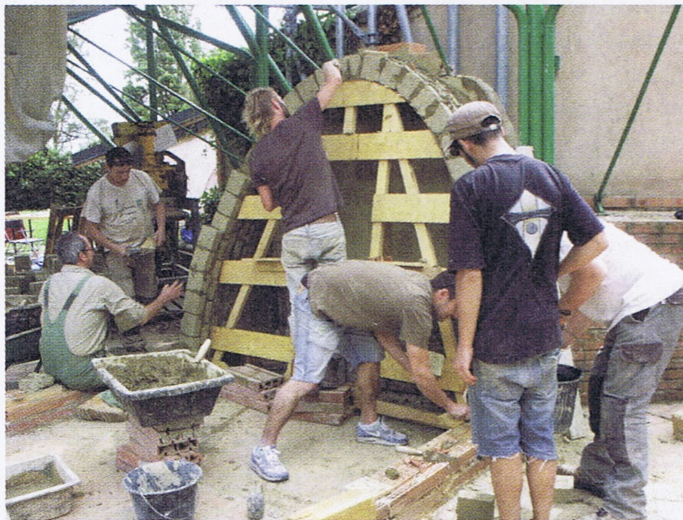
Stage de construction de voûte nubienne à Lavalette (Haute-Garonne).
